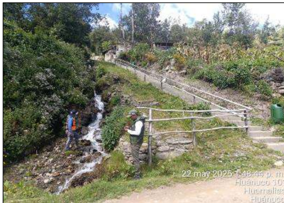
Figura 01. Se muestra la quebrada con cauce definido y encauzada parcialmente con muros de piedra. Al fondo se encuentra el centro poblado Micarin con viviendas cercanas al cauce. Dado que la quebrada atraviesa el centro poblado y no cuenta con infraestructura de protección adecuada ni encauzamiento continuo, existe riesgo de desbordamiento durante lluvias intensas, lo que podría afectar a las viviendas, caminos y servicios cercanos.
